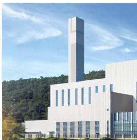
厦门垃圾焚烧发电厂项目
