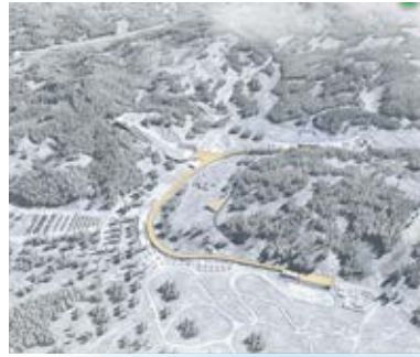
张家口赛区奥运村及古杨树场馆群钢结构工程
