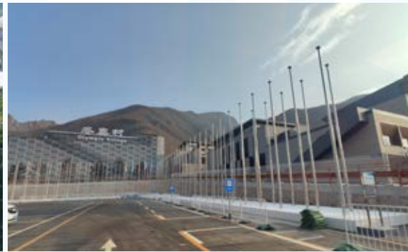
延庆赛区临时设施项目
