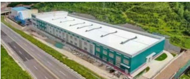
张家口市崇礼区二道沟热源厂煤改电项目
