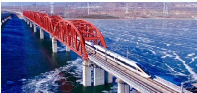
冬奥会配套重要交通基础设施检测项目
