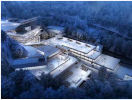
国家高山滑雪中心钢结构工程
